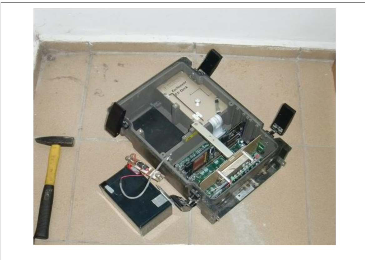
Фиг. 28. Анkerиране и монтиране на акселерограф “ETNA” в подземие в гр. Перник
