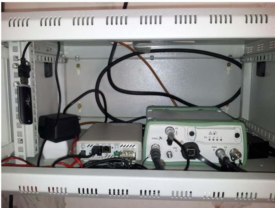
Фиг. 14. GNSS перманентен приемник Leica GR10 инсталиран в гр. Трън
