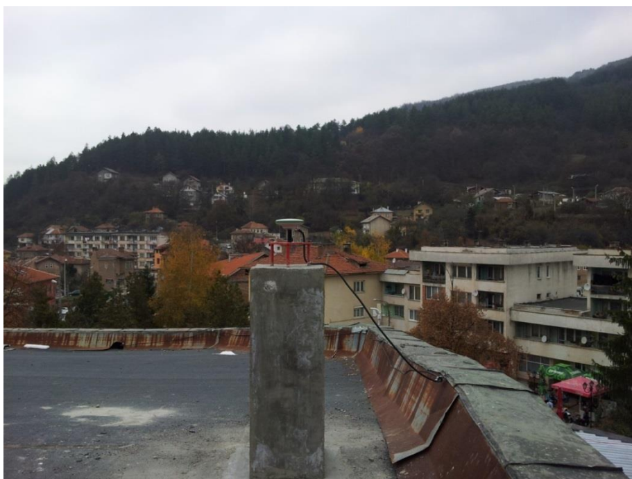
Фиг. 13. Изграденият стълб за принудително центриране на GNSS антената в гр. Трън
