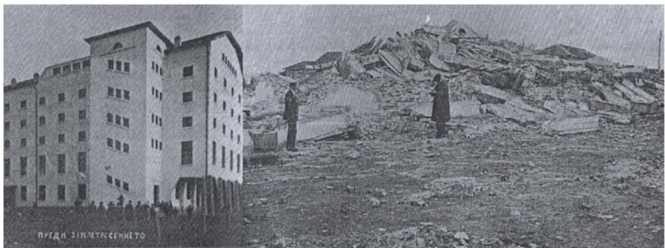
Фиг. 1. Разрушения след земетресението от 14 април 1928 г., град Чирпан
